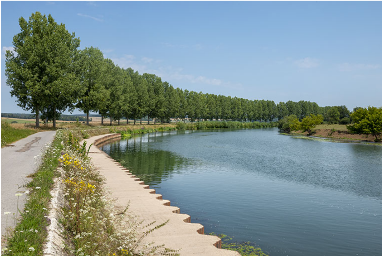
Vue vers l'amont depuis l'entrée du canal.
