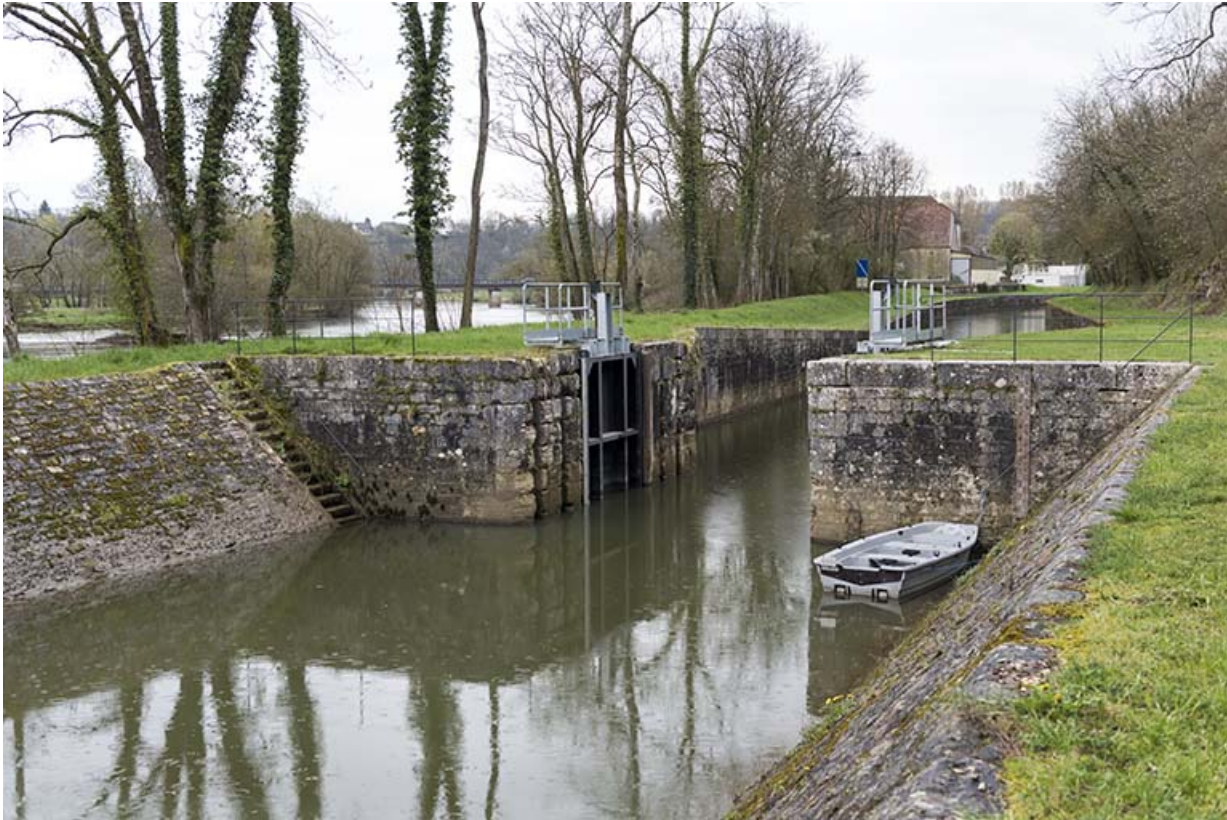
La maçonnerie de la porte de garde.
