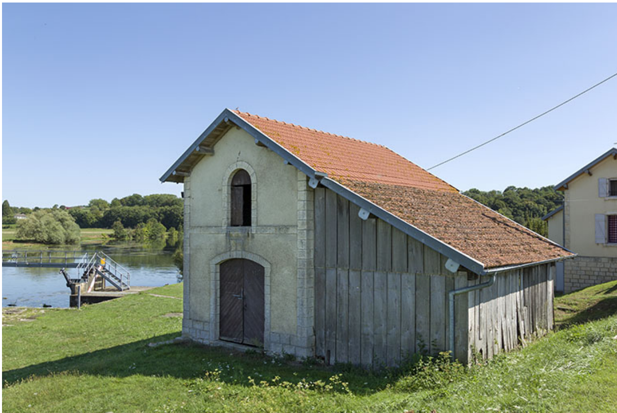
Magasin à aiguilles du barrage.
