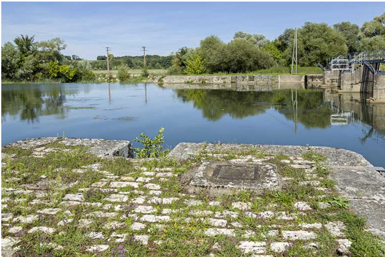
Emplacement de l'ancien barrage à aiguilles.
