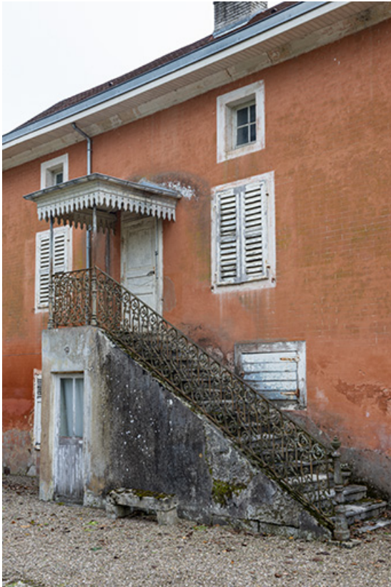
Façade nord, perron.
