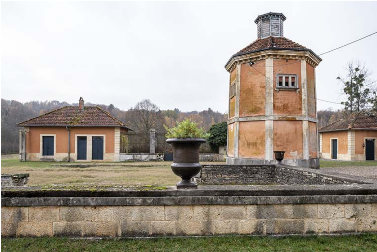
Pigeonnier, vue depuis l'est.
