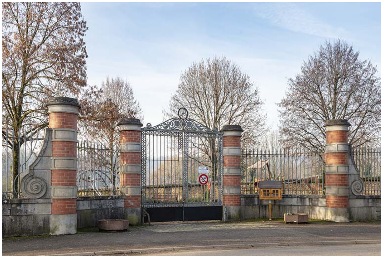
Clôture (grille) sur l'avenue des Pâtis.
