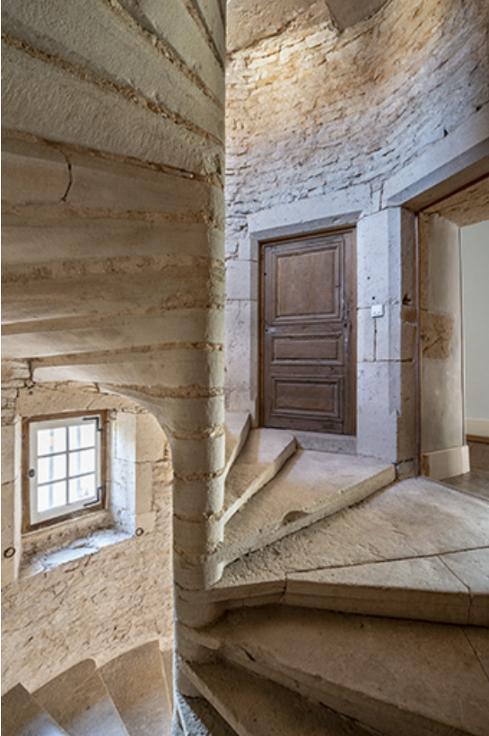
Escalier en vis, premier étage.
