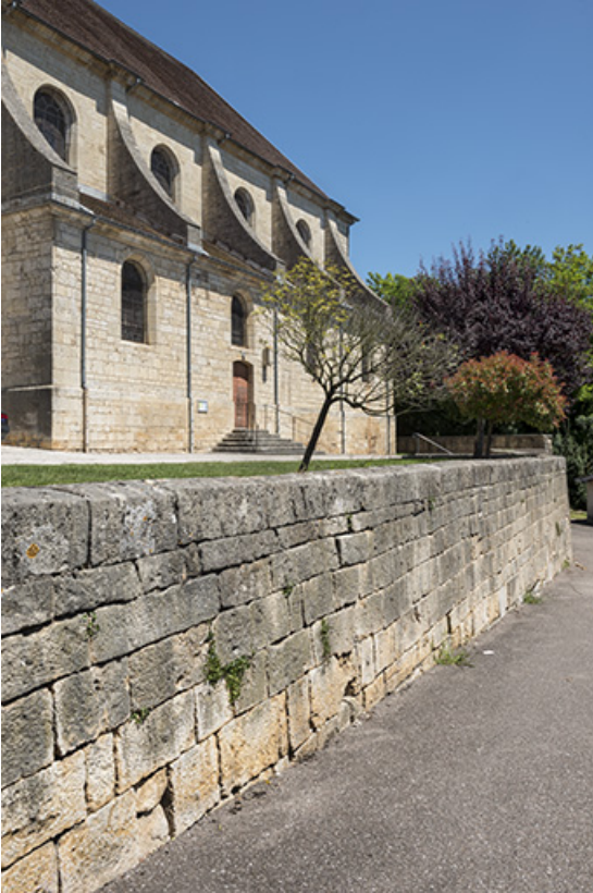
Flanc sud, mur de l'ancien cimetière.
