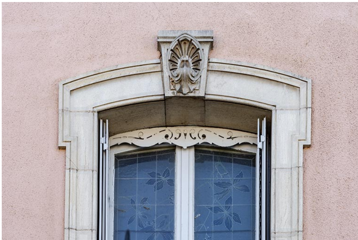
Fenêtre avec clé de voûte, façade antérieure.
