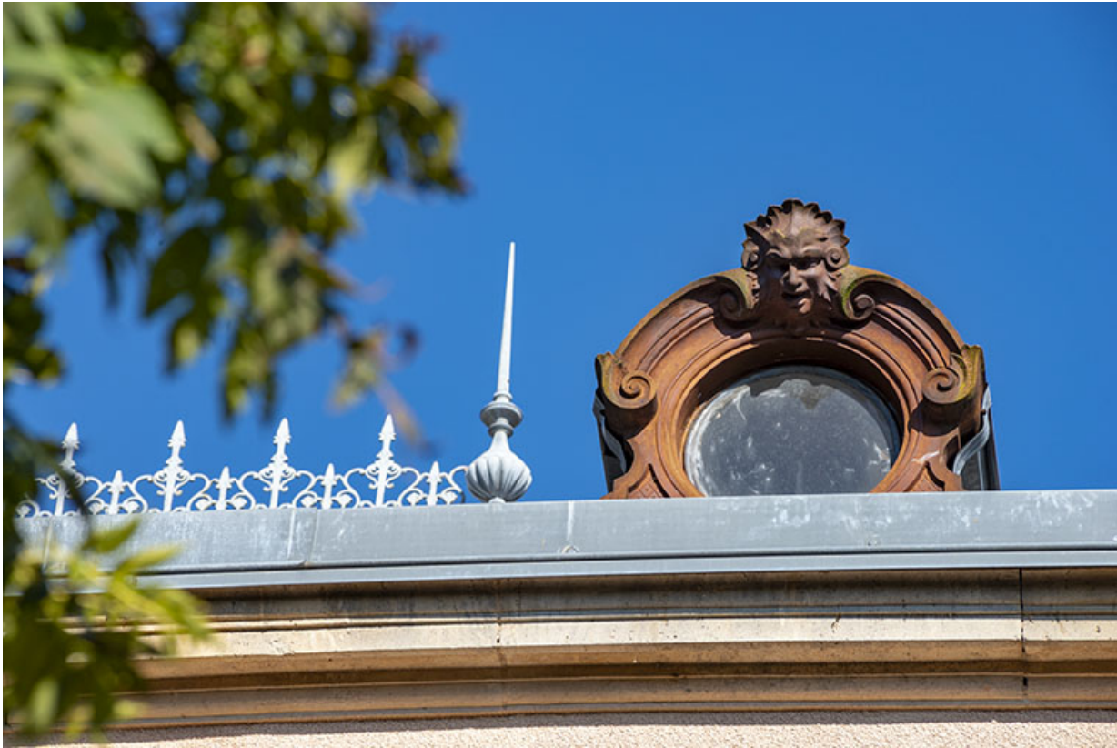
Lucarne, façade postérieure.
