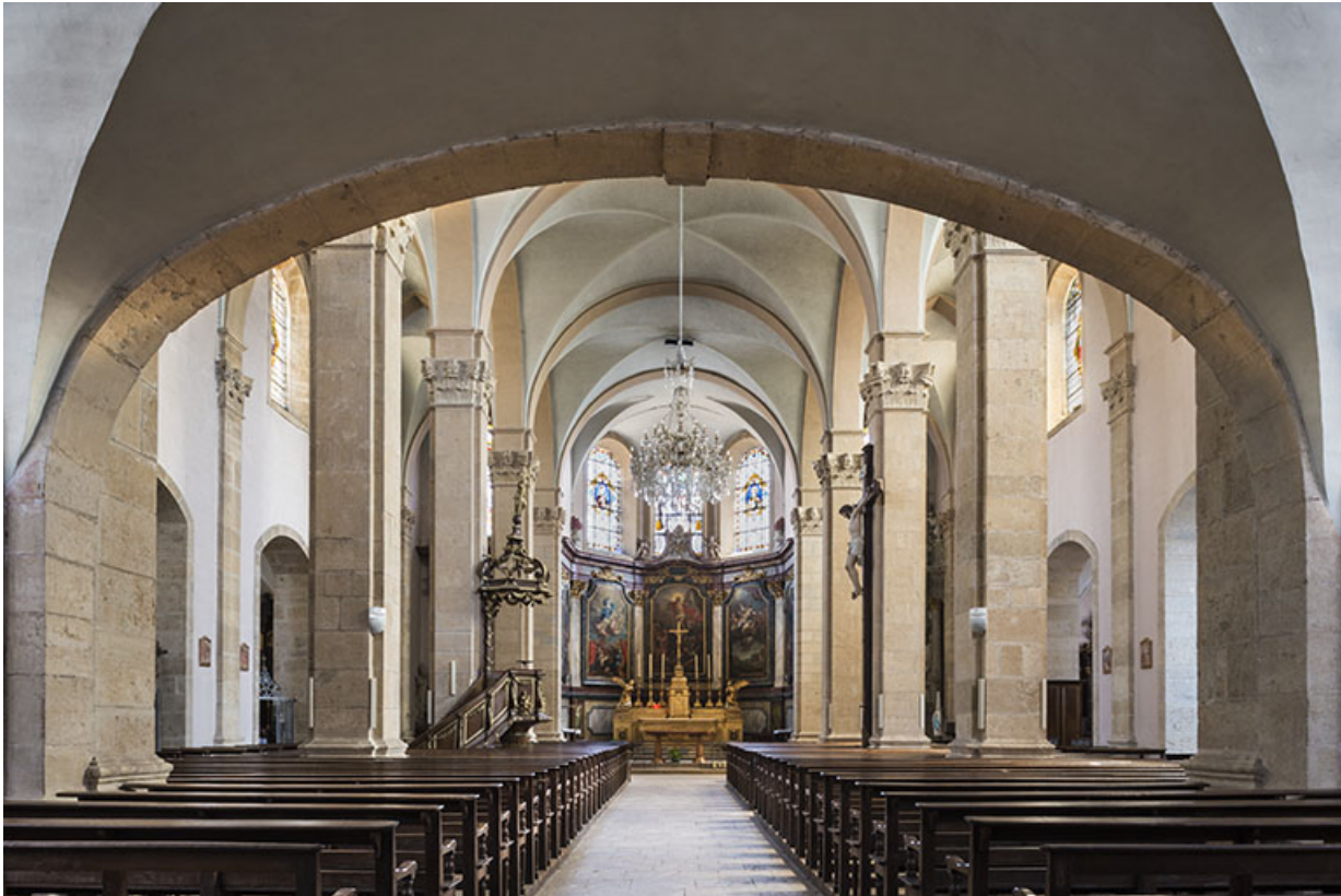
Nef, vue en direction du chœur.
