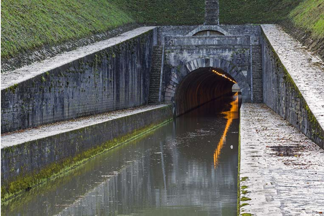
Le tunnel de Saint-Albin.
