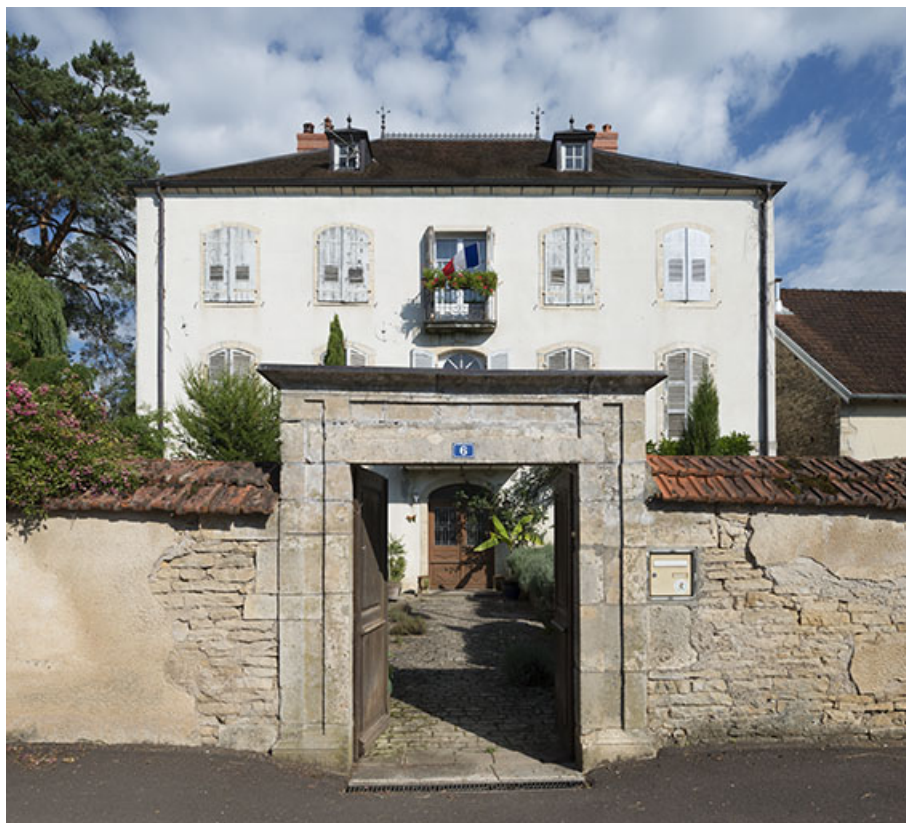
La façade antérieure et le portail d'entrée.
