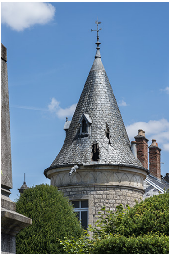
Toiture de la tour.
