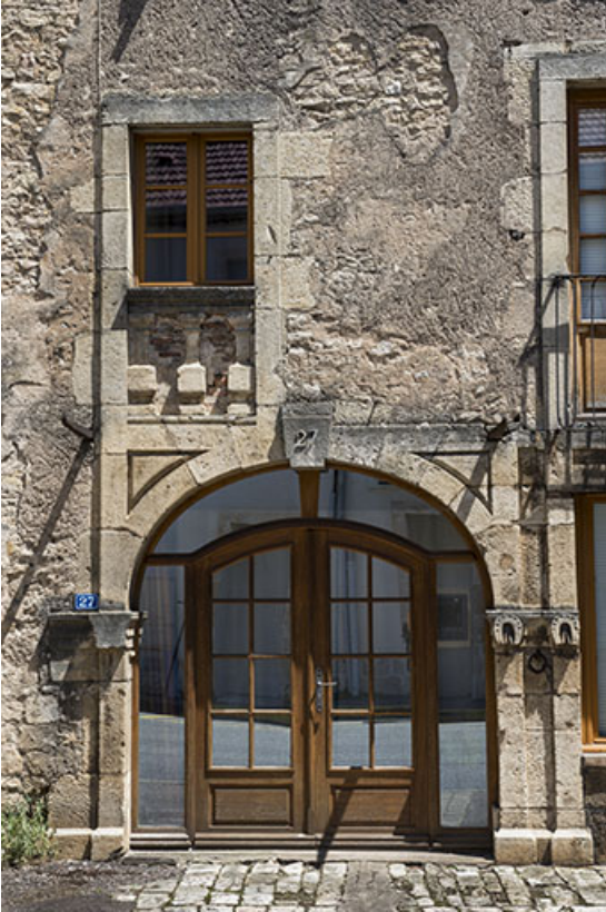
Baies du rez-de-chaussée et du premier étage.
