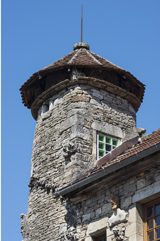
Dernier niveau et couverture de la tourelle.
