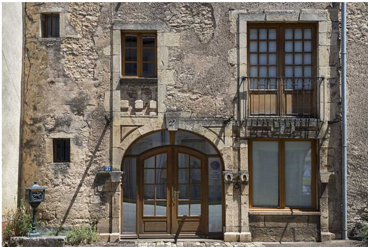
Baies du rez-de-chaussée et du premier étage.
