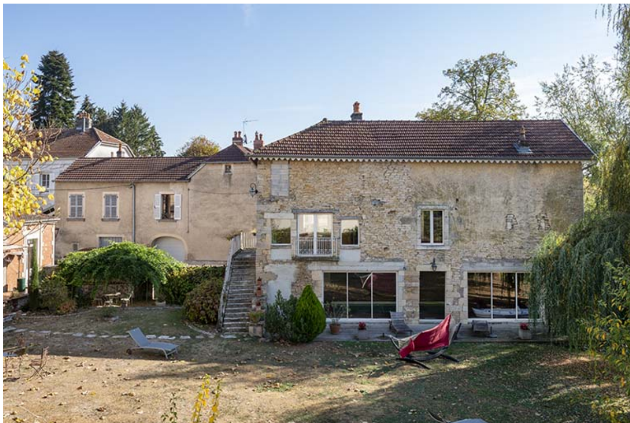
L'ancien bâtiment à usage de tannerie.
