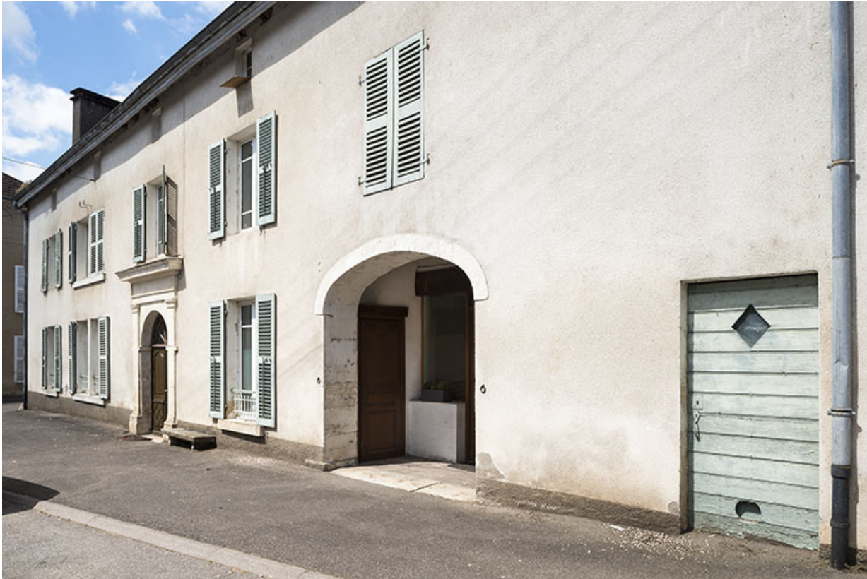
Portail sur la façade antérieure.
