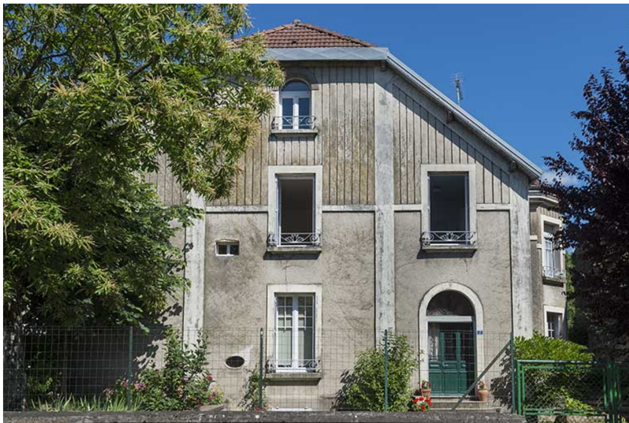
Maison côté rue de la Perception.
