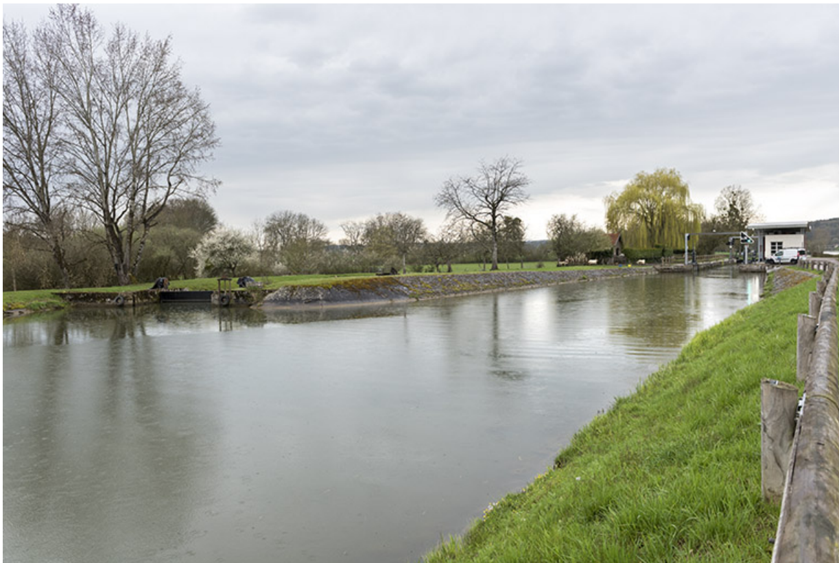
La dérivation et le bassin à radoub.
