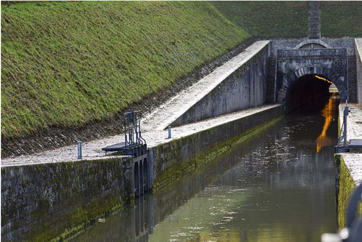
Le tunnel, vue amont.
