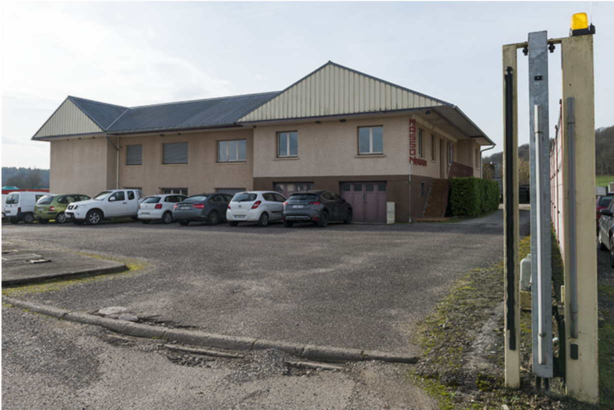
Les bureaux, vue de trois-quart.
