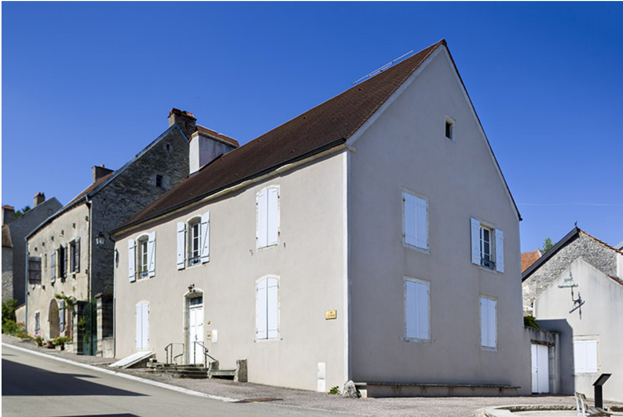
Vue générale de trois quart droite.
