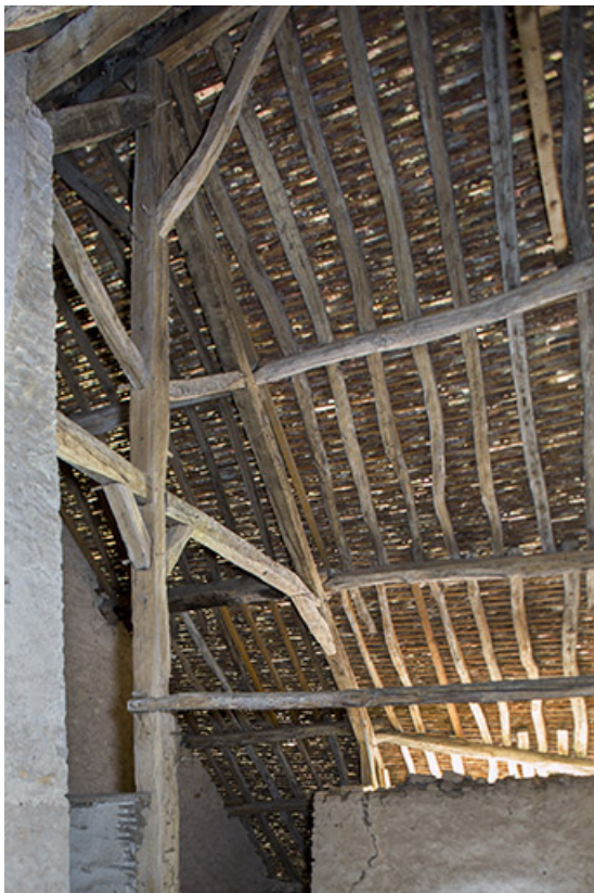
Intérieur : détail de la charpente.
