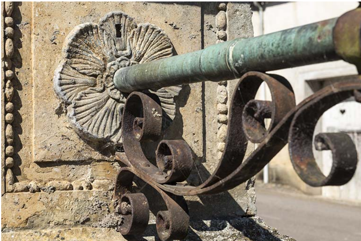
Détail du jet en fonte.
