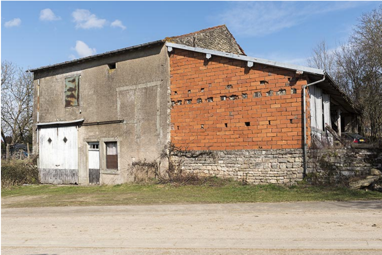
Maison rue des Canes.
