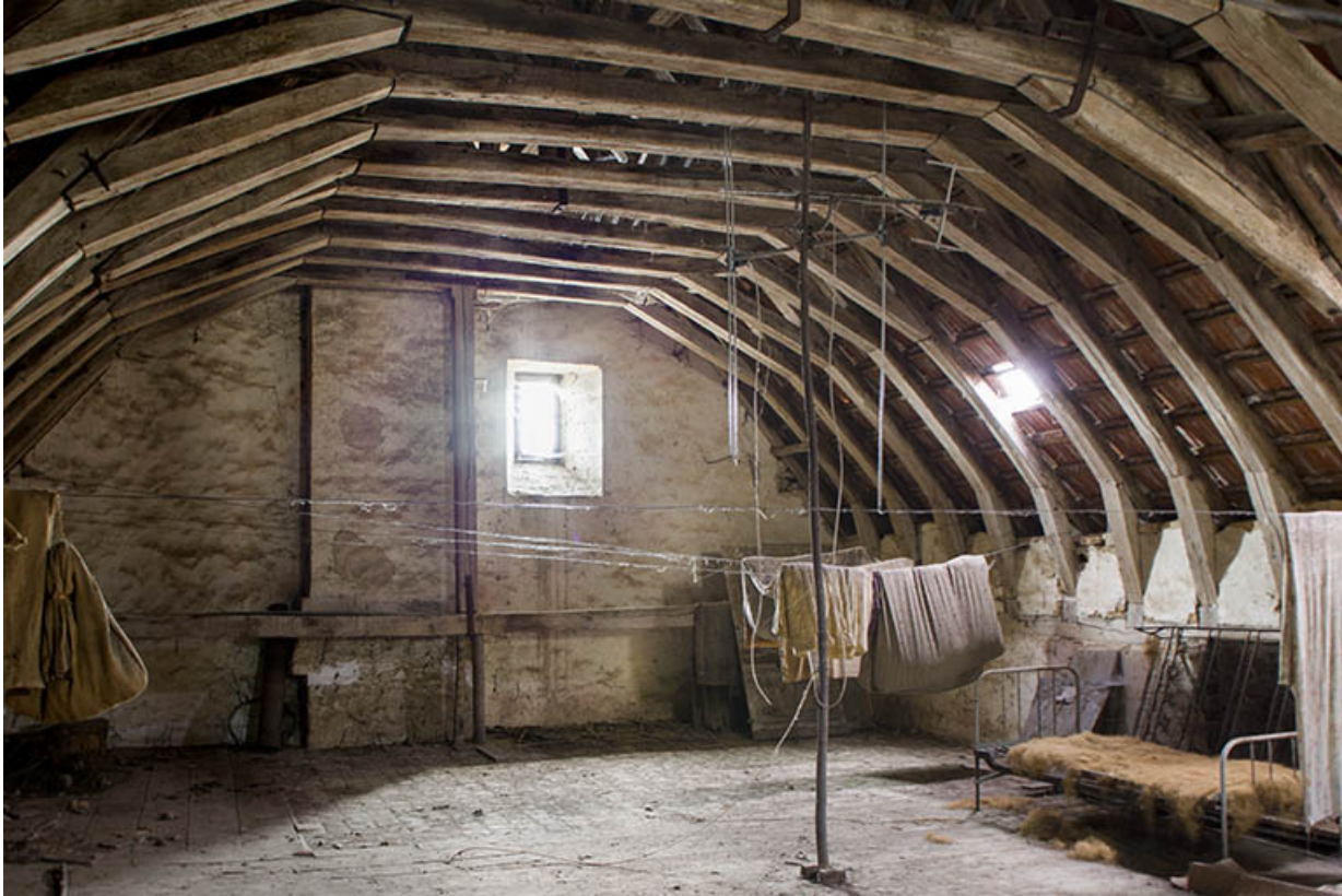
Vue générale de la charpente.
