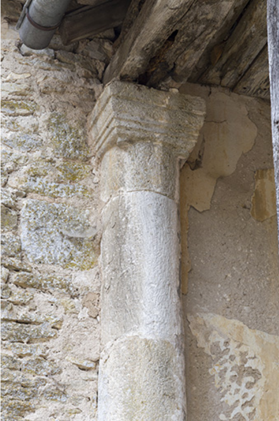
Colonne adossée au mur du premier palier.
