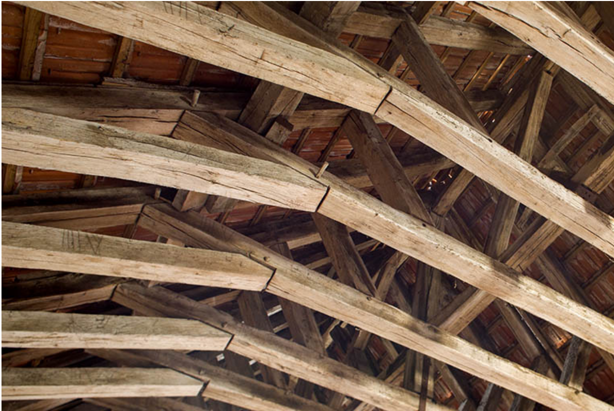
Détail de l'assemblage de la charpente.
