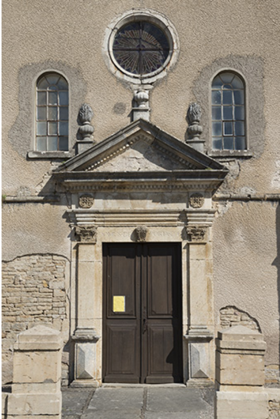
Vue avant restauration (2016).
