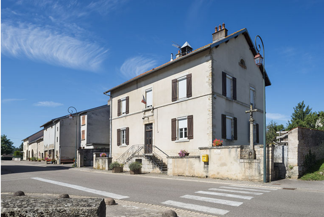
Vue d'ensemble de la maison commune.
