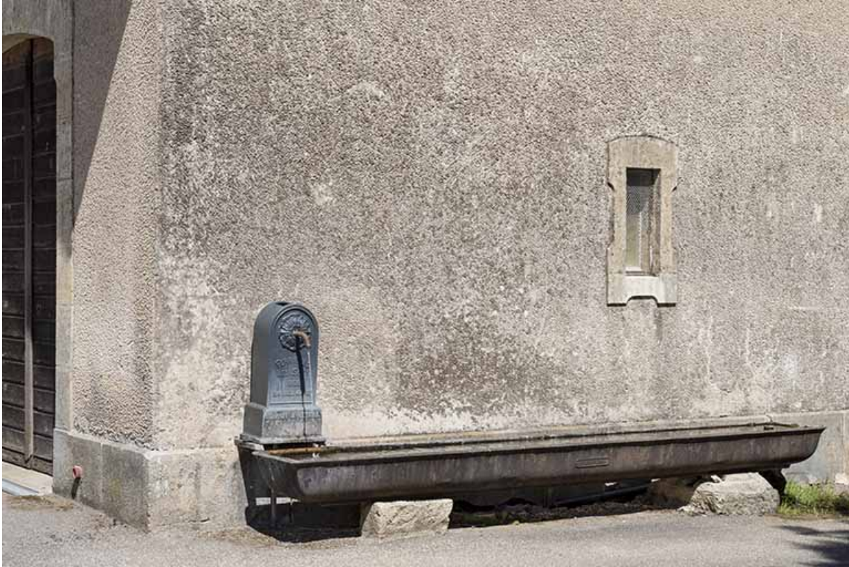
Abreuvoir situé contre la façade droite.
