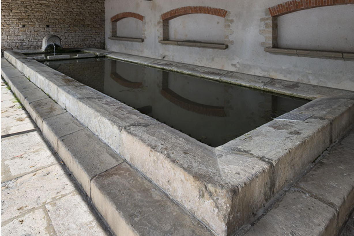
Bassin du lavoir.
