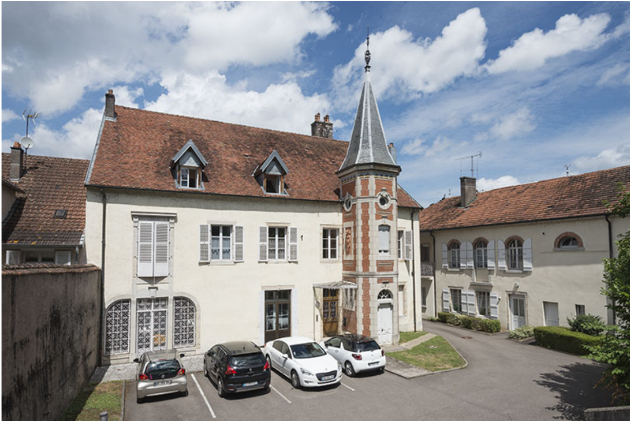
Façade postérieure de la demeure.
