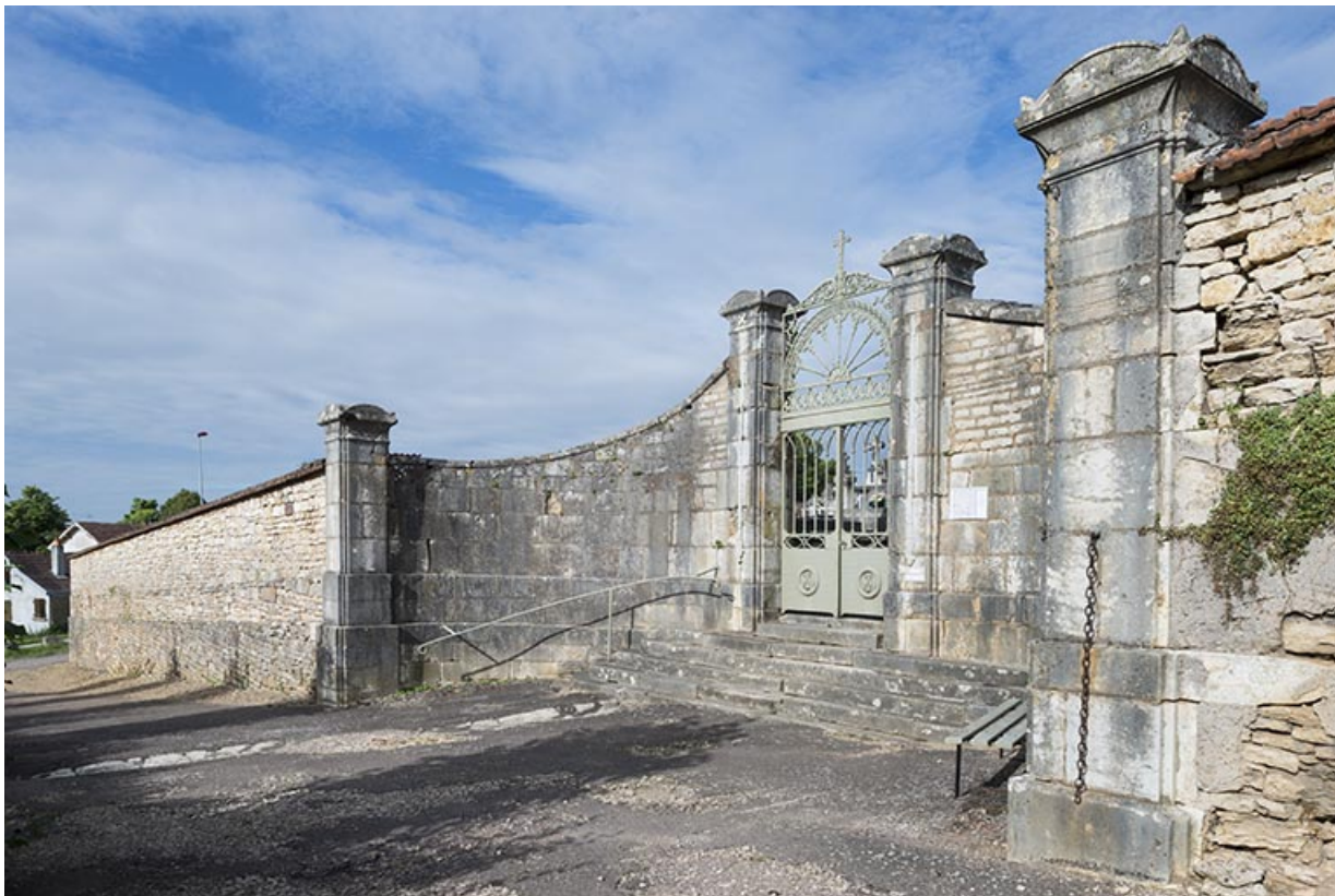
Vue depuis le haut de la rue.
