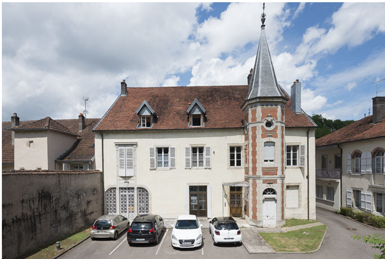
La façade postérieure.
