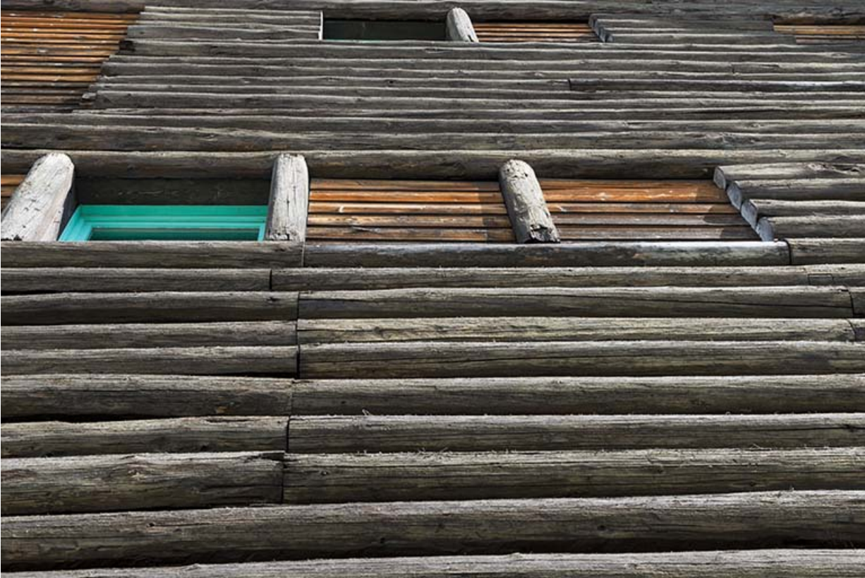
Le mur recouvert de demi-rondins de sapin.
