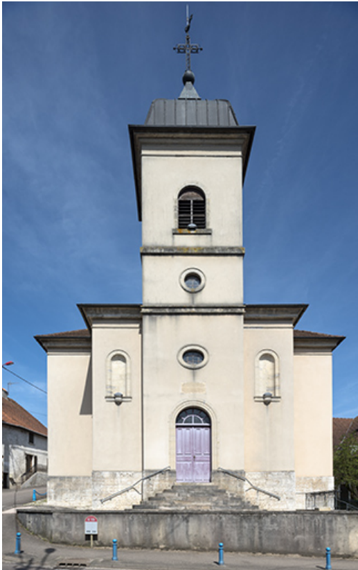
La façade antérieure de la chapelle.
