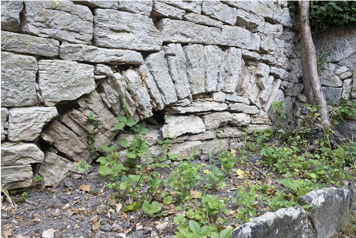
Détail sur la maçonnerie d'une voûte.
