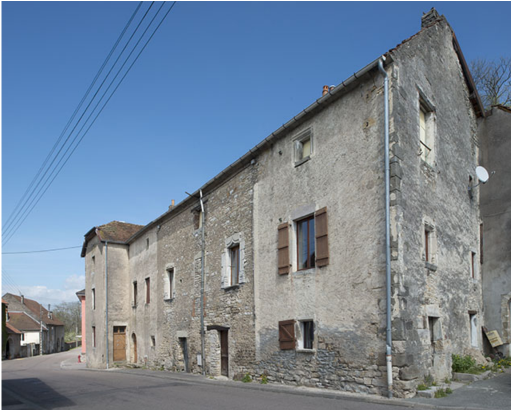
Vue générale de l'édifice depuis le Sud.
