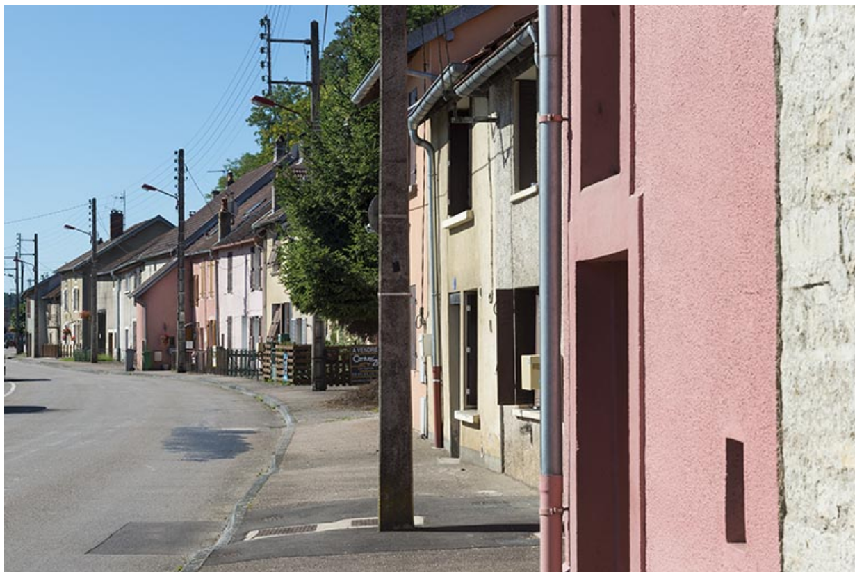
Rue du Magny. 70, Port-sur-Saône
