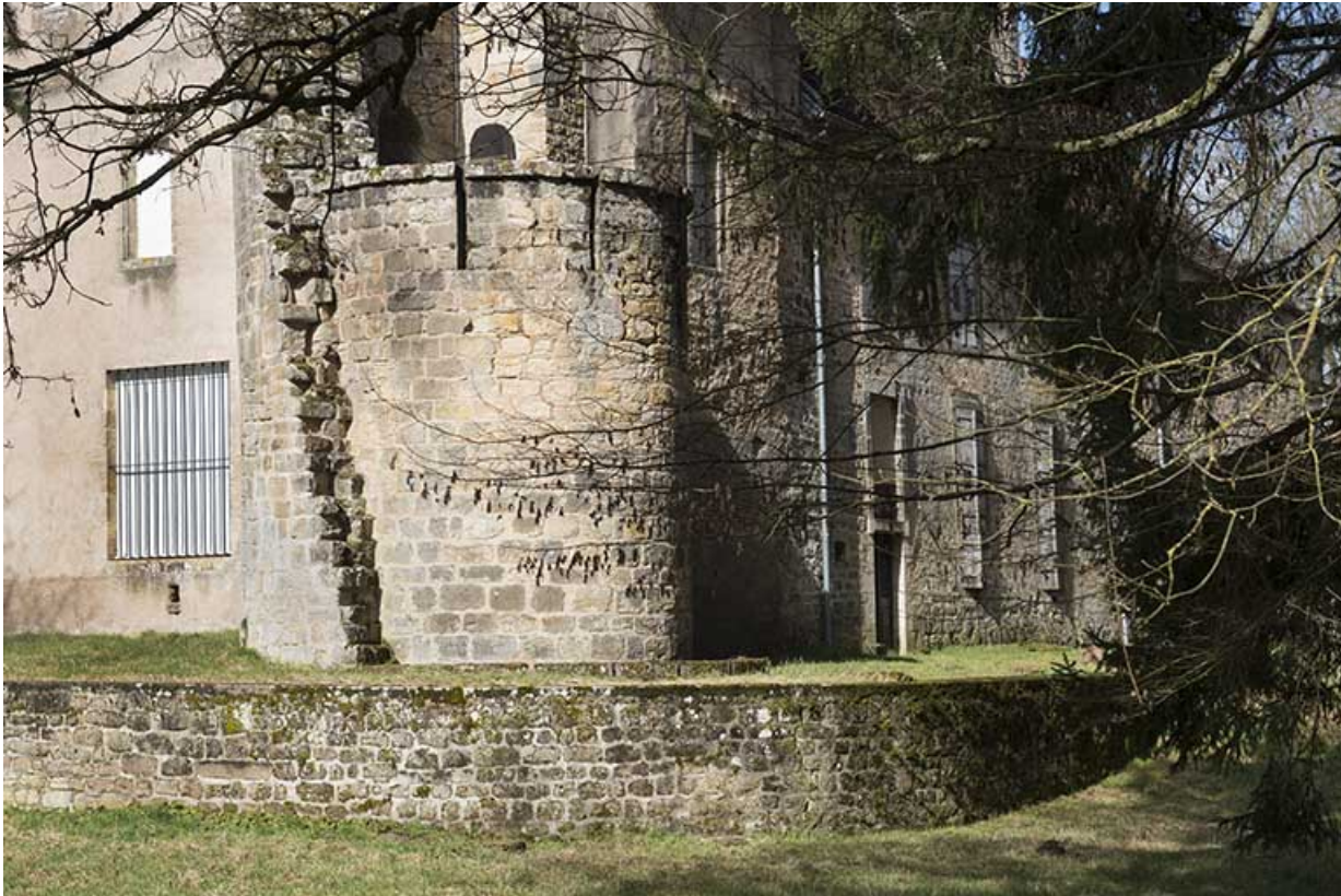
Détail sur la maçonnerie de la tour.
