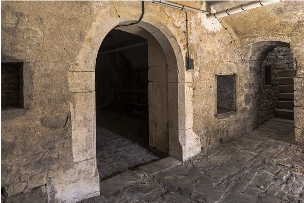
Porte de séparation de la cave.
