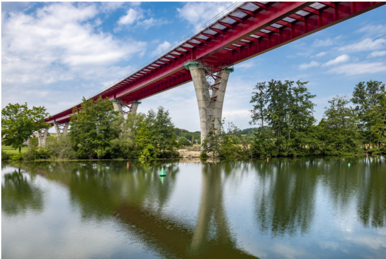
le viaduc en construction (déviation de Port-sur-Saône).
