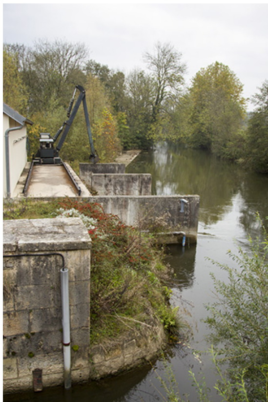
Appareil lié à l'entretien du canal.
