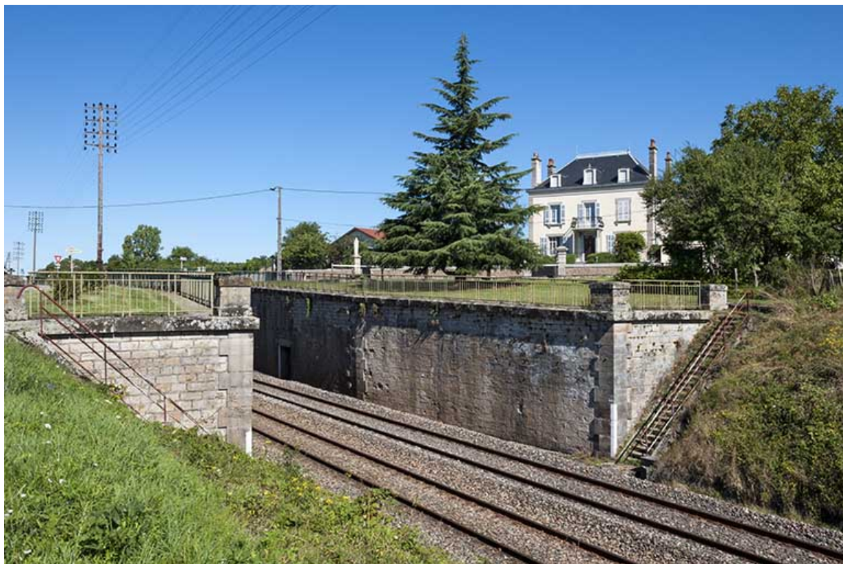
Voie ferrée traversant le village
