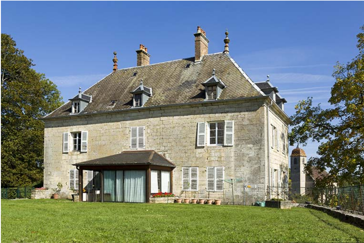
Façade antérieure et façade latérale droite.
