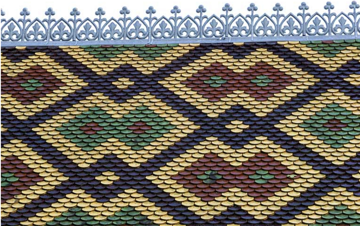
Détail : crête de toit.
