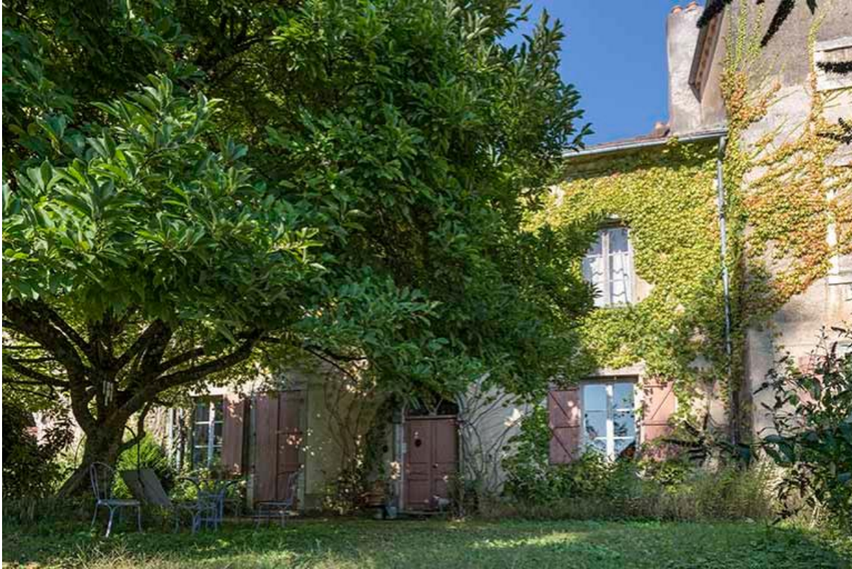
Aile du château et jardin, côté Sud-Ouest
