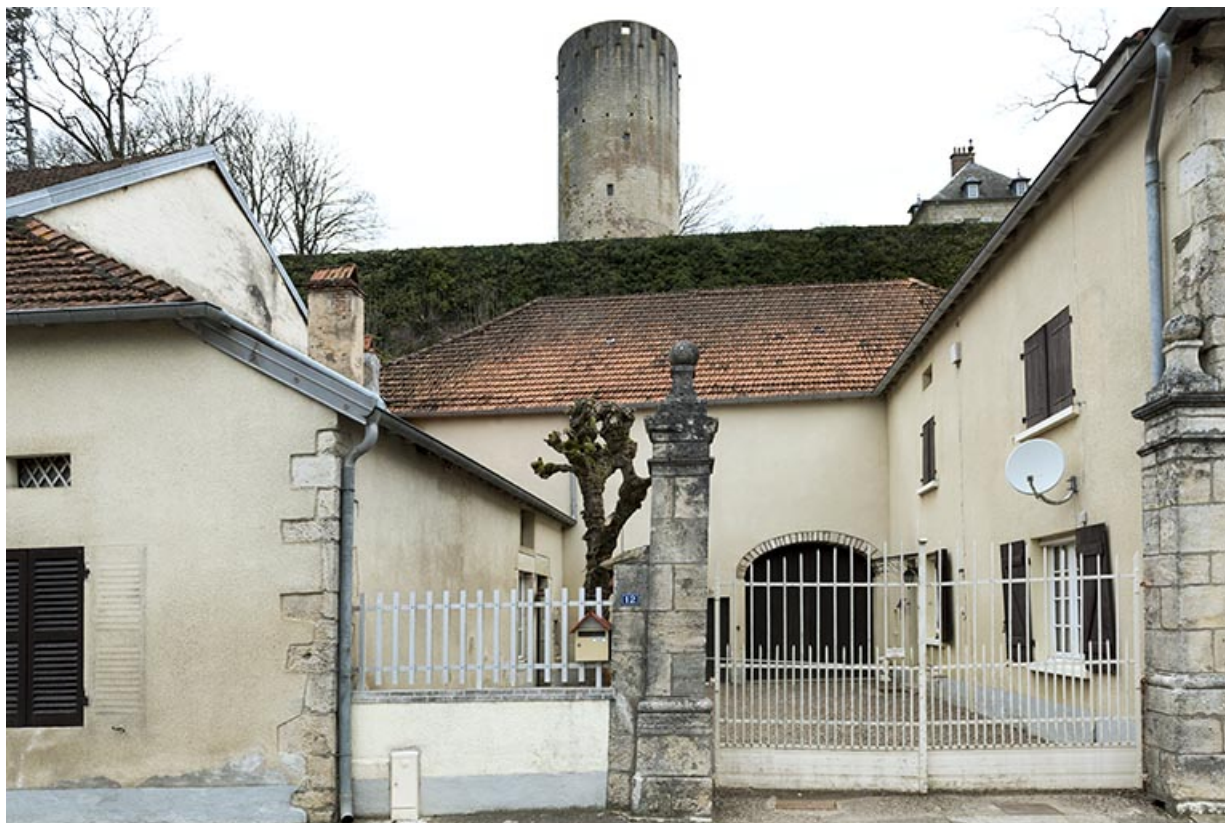
Vue générale depuis la rue du Pâquis
