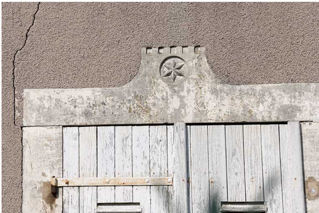
Détail du décor sur les linteaux.
