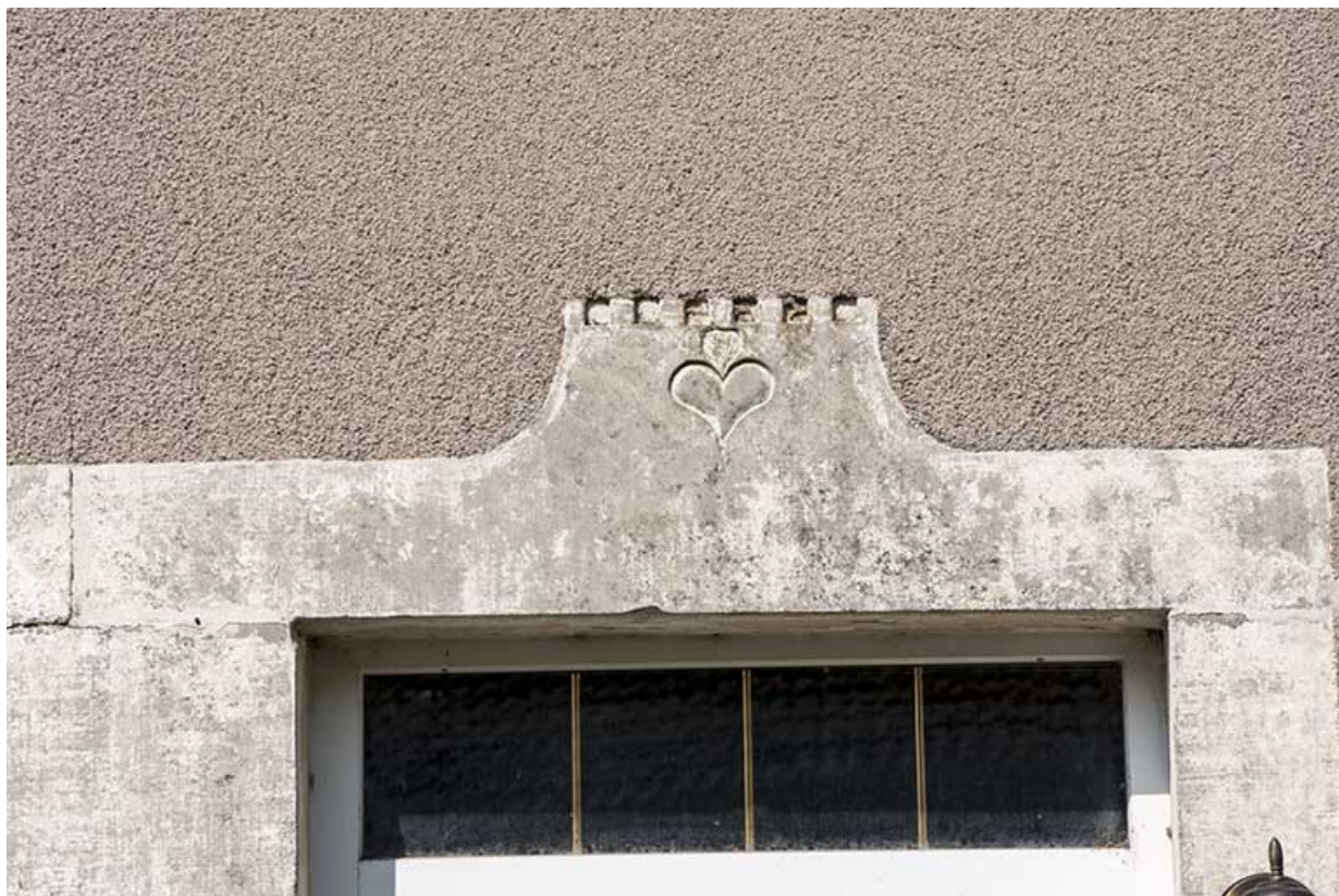
Détail du décor sur les linteaux.
