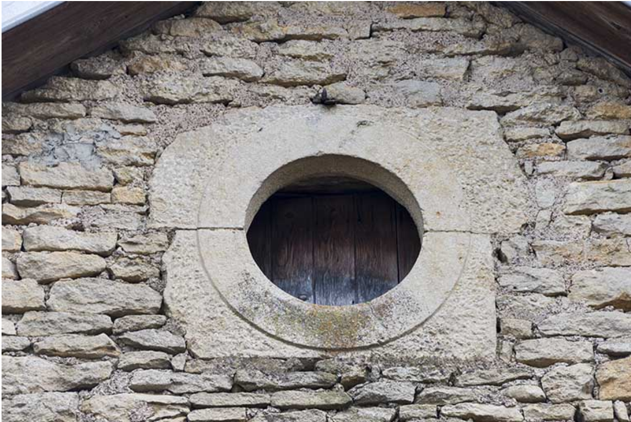
L'oculus, sur le pignon de la maison.
