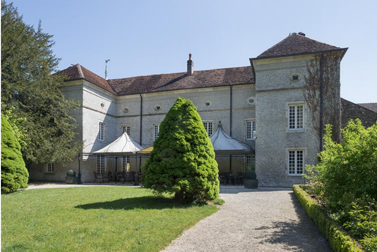
Vue générale, façade postérieure.
