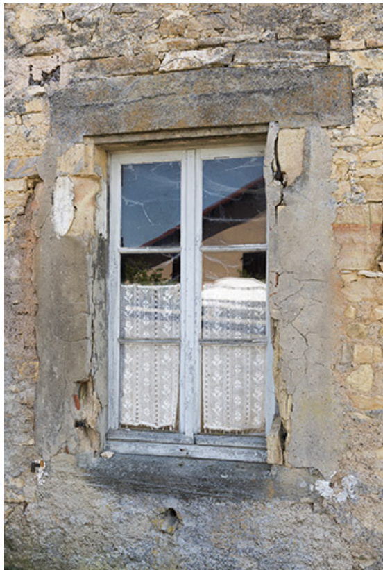
Détail d'une ouverture, mur pignon.
