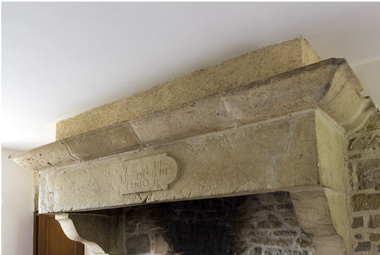
Cheminée dans la ferme côté rue.
