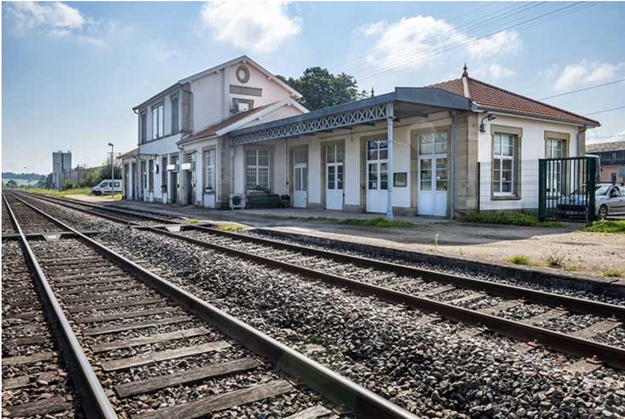
La gare, vue éloignée depuis les voies.
