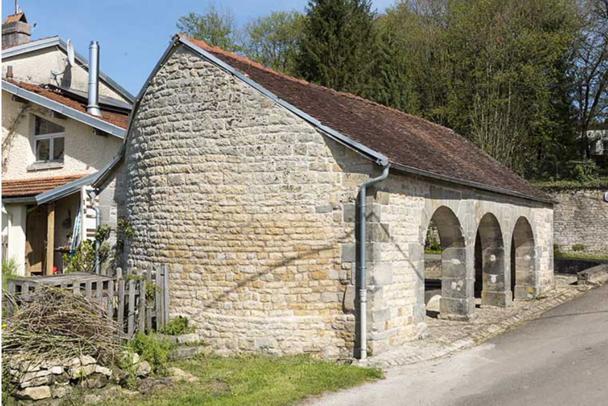
Mur pignon du lavoir. 70, Aisey-et-Richecourt
